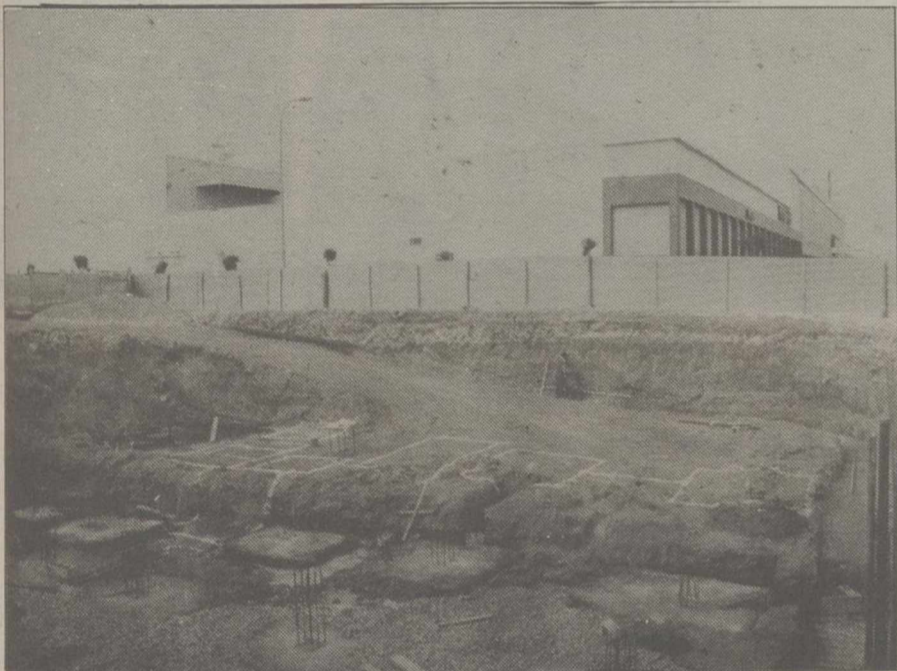
C/ G. MENDEZ PARADA ESQUINA FERNANDO POO 20 VIVIENDAS CON PLAZA DE GARAJE Y LOCALES.
