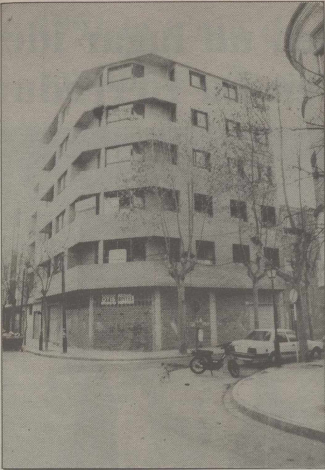
CONSTRUCCION 10 VIVIENDAS Y LOCALES BLASCO IBAÑEZ CON JOAQUIN QUIJADA
