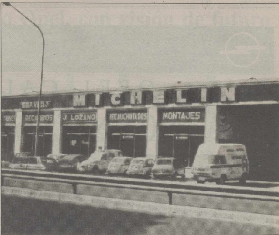
Instalación de Michelin.
