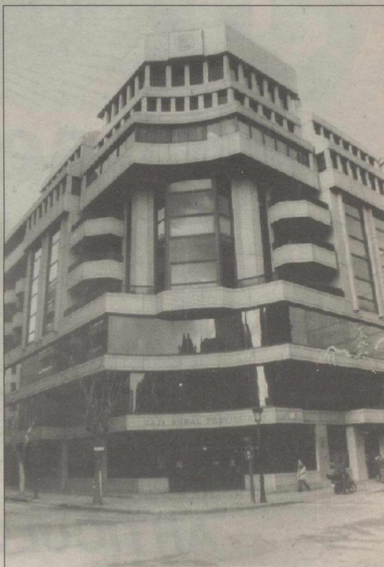
Edificio de la Caja Rural.
