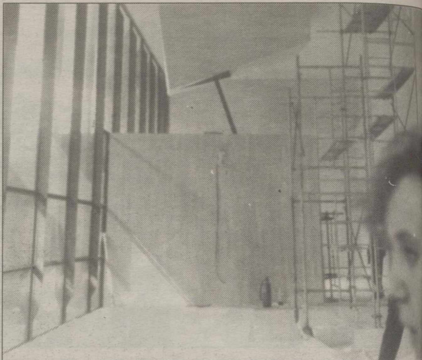
Detalle del techo de madera de la sala de proyecciones.
