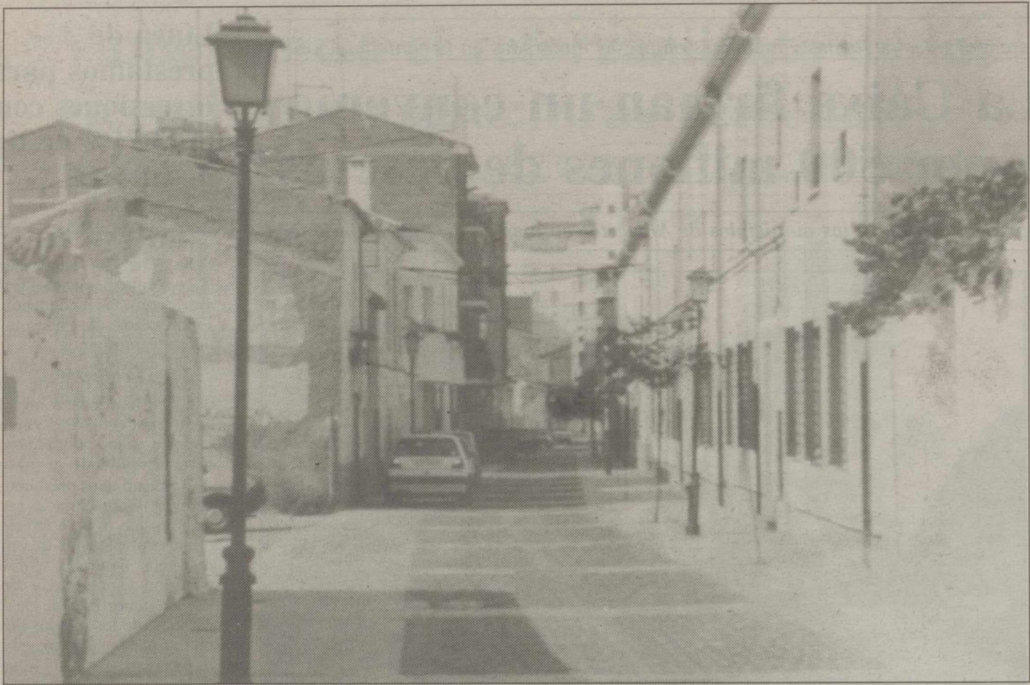
Las obras de reparación de los desperfectos de las 90 viviendas de promoción pública (a la derecha) comenzarán en breve plazo de tiempo.
