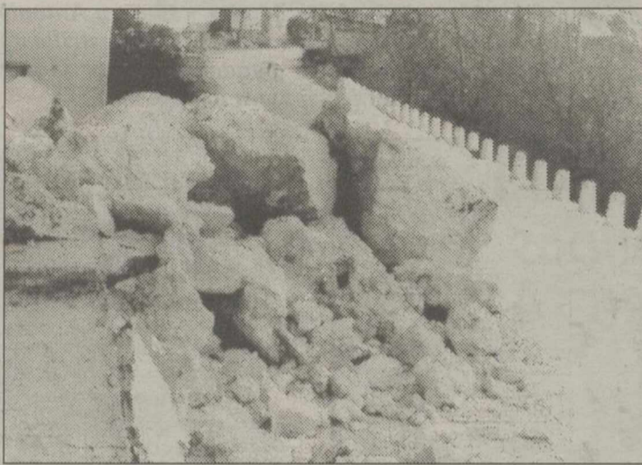
Desprendimientos en Almería.
