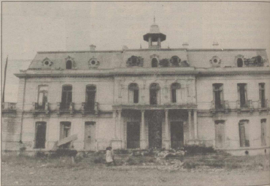
Ya en 1987 el Ayuntamiento denunció ante la Consejería de Cultura su abandono solicitando su rehabilitación.
