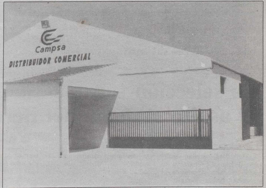
NAVE CON UNA SUPERFICIE DE 500 M 2 , EN DONDE SE ENCUENTRAN UBICADAS LAS OFICINAS Y COCHERA.
