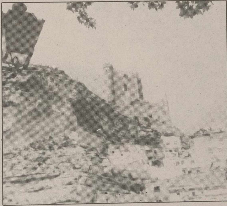
Vecinos de Alcalá del Júcar temen que se produzca otro derrumbamiento.
