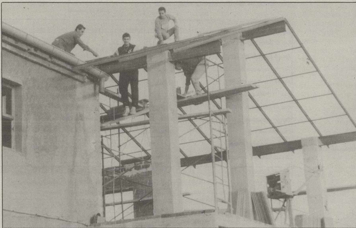
Los jóvenes realizan obras de ampliación del "Molino de Sierra", centro que es para ellos una "escuela de vida".
