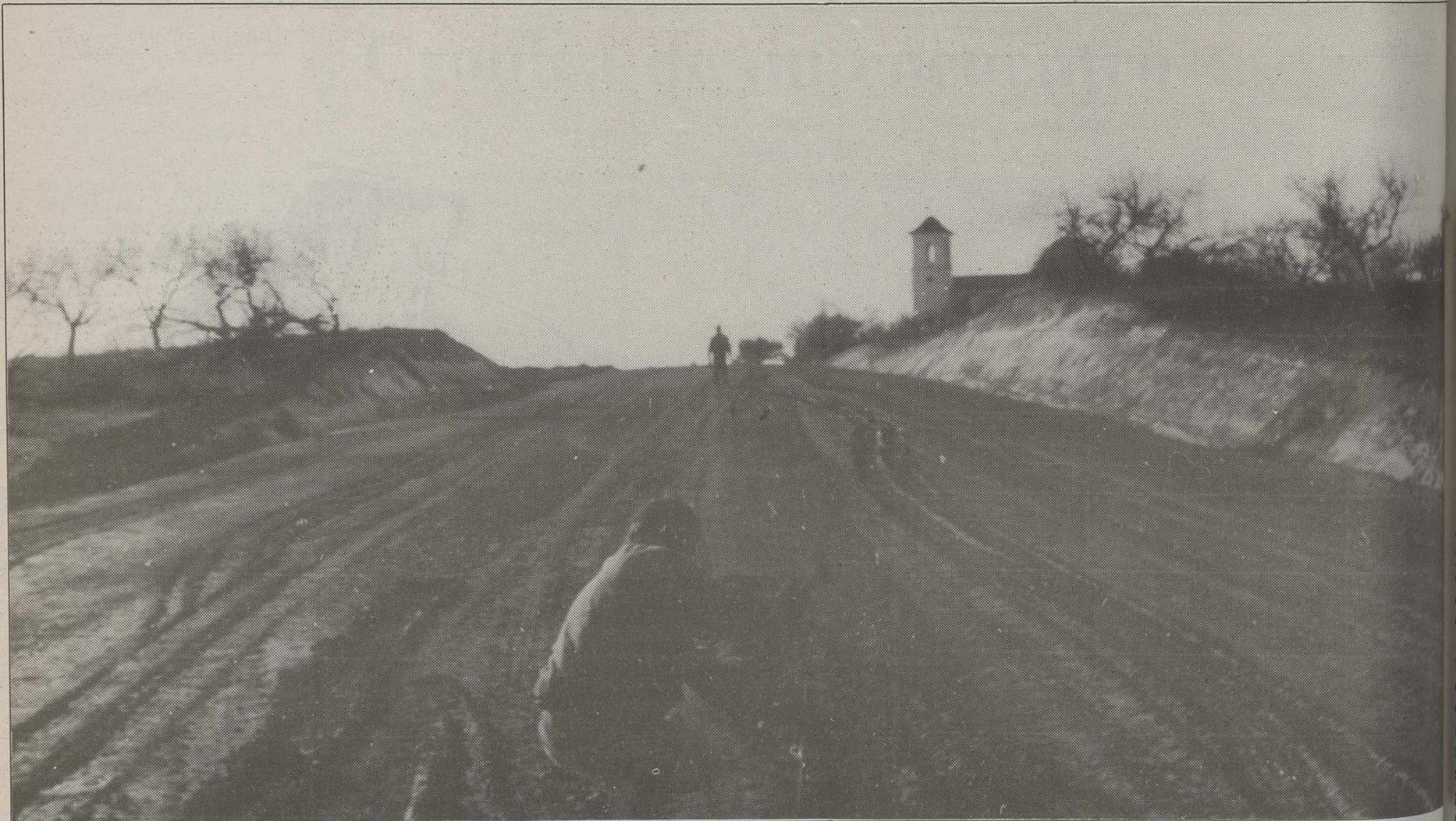
Llano de la Consolación, a la derecha de las obras está la boca del horno.
