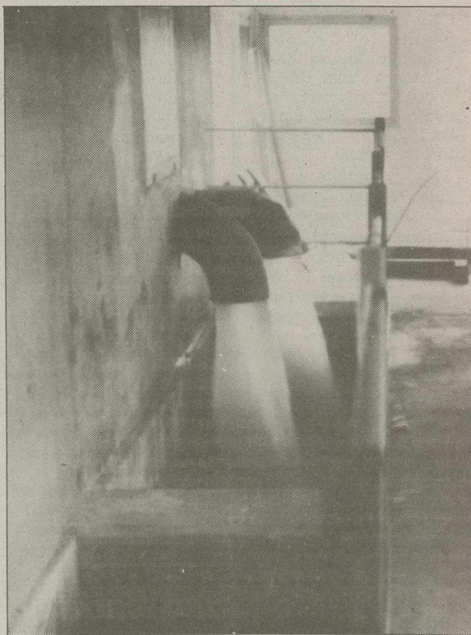
La actual depuradora nunca ha llegado a funcionar a pleno rendimiento.
