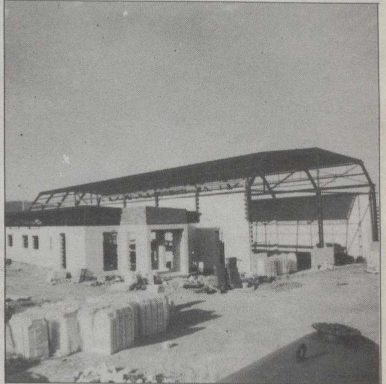
Actual estado de la construcción de la ITV hellinera.
