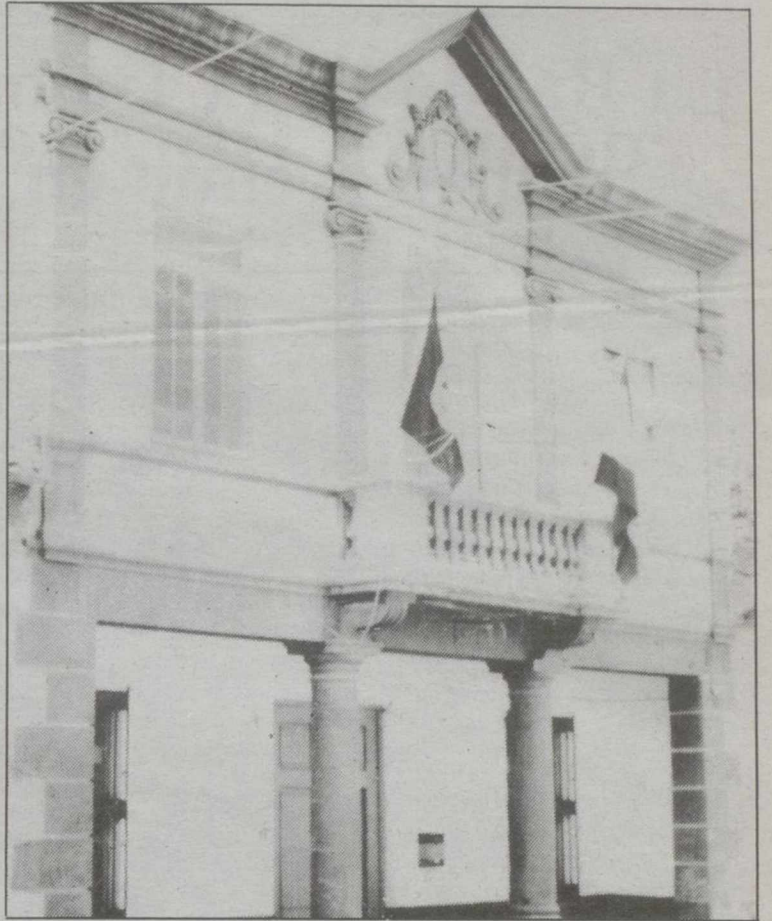
Fachada del Ayuntamiento de Alatoz.
