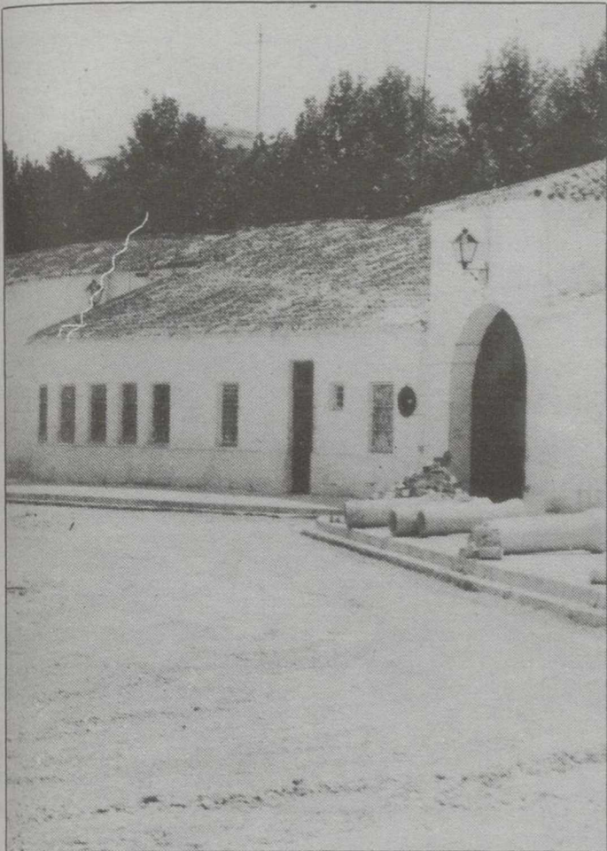
El adoquinado de parte de los Ejidos de la Feria, una obra "urgente".
