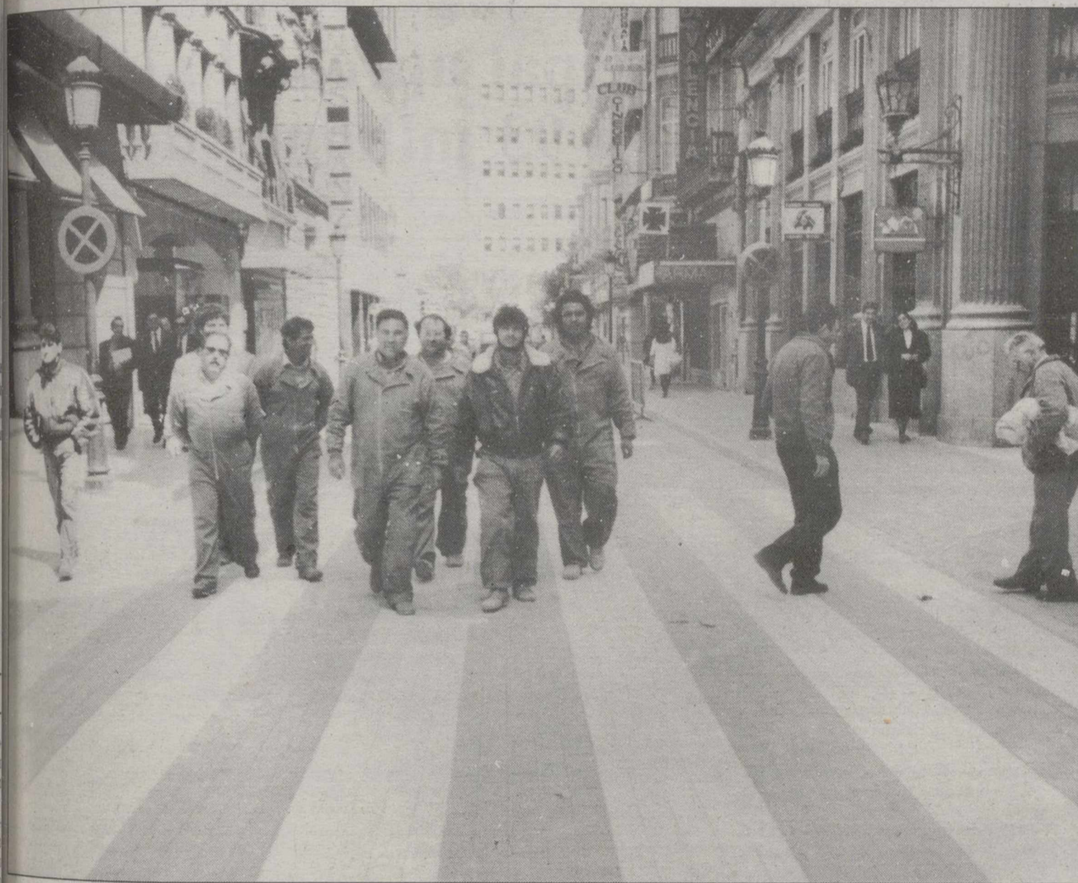
Con una especie de "marcha triunfal" los trabajadores abandonaron la calle Marqués de Molins una vez finalizadas las obras. JESUS MORENO
