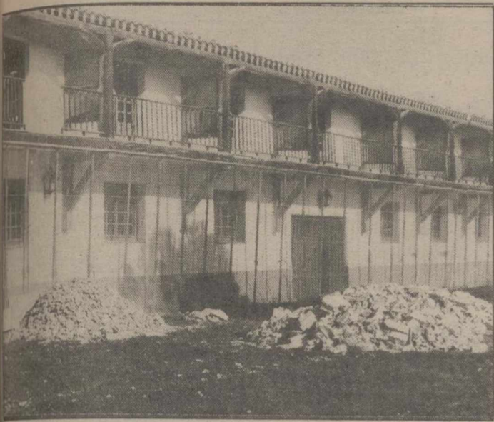
Las habitaciones del Parador están siendo reformadas.
