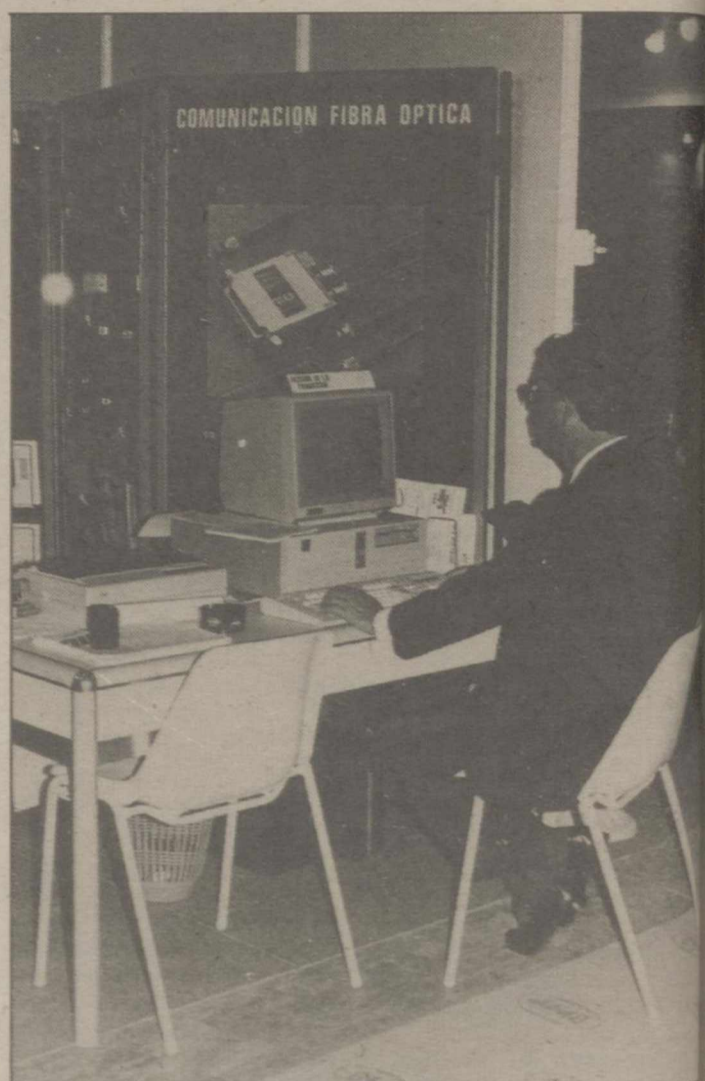
Comunicaciones por fibra óptica.
