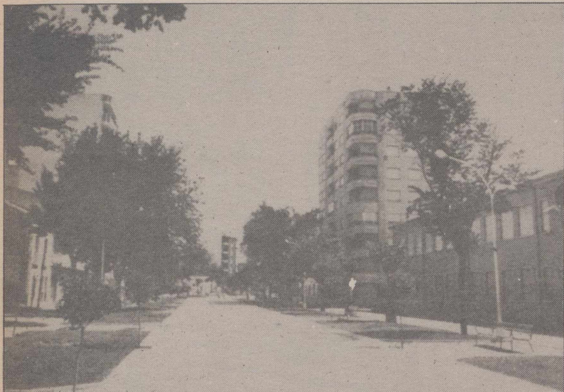
El Paseo de la Estación perspectiva de una ciudad moderna.
