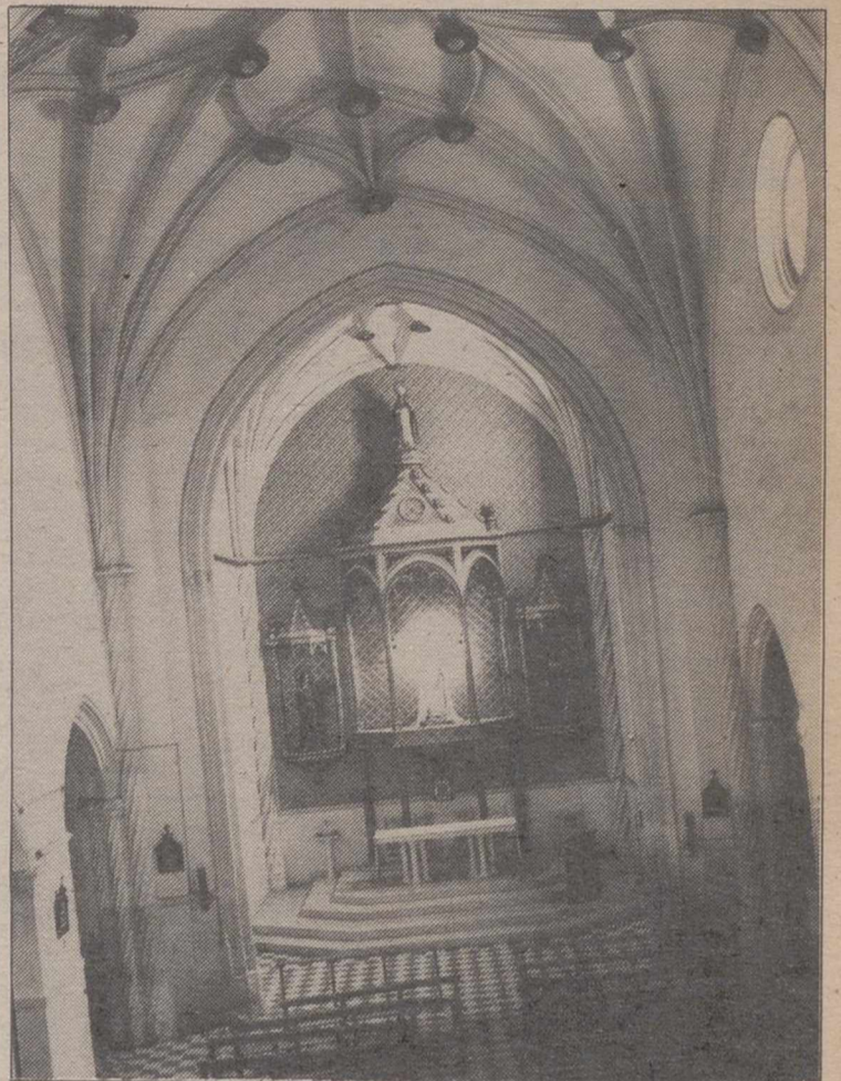
La segunda fase de la restauración costará cinco millones de pesetas, que ya se han recibido en el Ayuntamiento, procedentes de la Junta de Comunidades.
