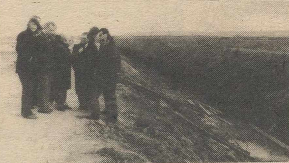
Los altos funcionarios del Mopu y técnicos del Ayuntamiento inspeccionaron las obras con el alcalde.
