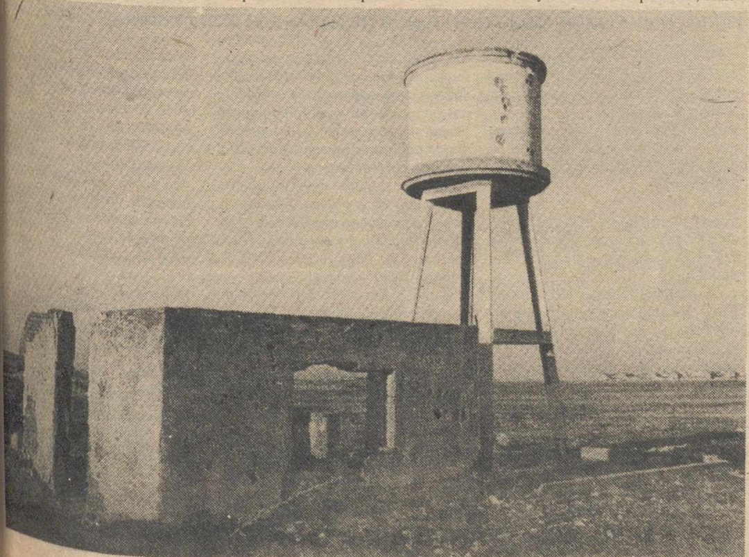
De estos últimos edificios sólo quedan escombros.
