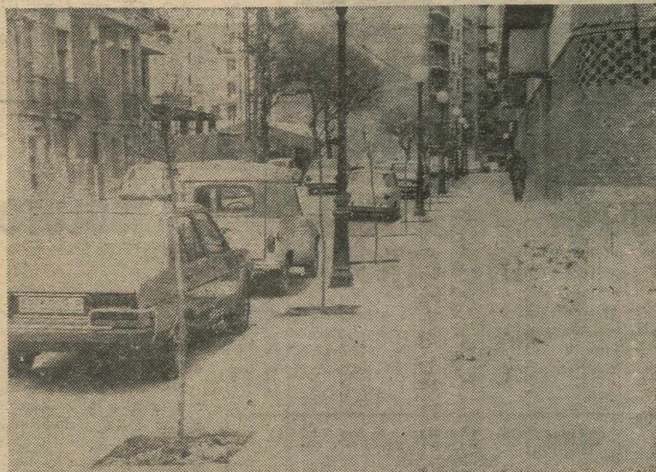
La calle de la Cava, angosta, sucia y mal pavimentada ha pasado a la historia de la ciudad. La urbanización de Villacerrada, con un notable retanqueo, ha permitido su ensanche. Hoy es una de las más hermosas de Albacete. Y por si le faltaba algo, el Ayuntamiento ha procedido a la plantación de árboles, que esperamos lleguen a mayores. — (Foto José Luis)
