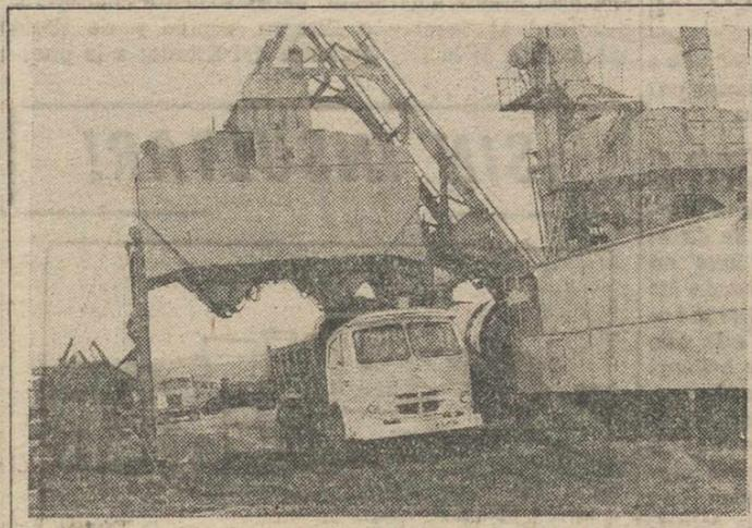
Hacen falta 100.000 m<sup>3</sup> de áridos para la construcción de una autopista. Los Pegaso 3.060 L, de 200 cv. los transportan.
