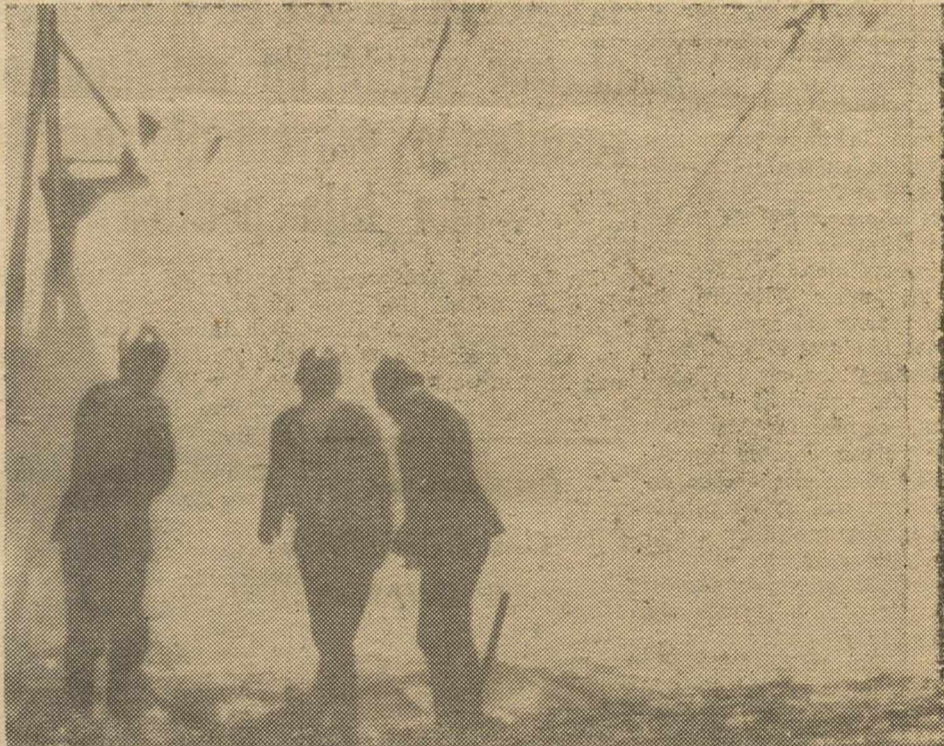
VALENCIA. —Un aspecto de los destrozos causados por un incendio en el pabellón metálico, que constituía el Parador del Sonelo de la Falla del Convento de Jerusalén.—(Telefoto CIFRA)
