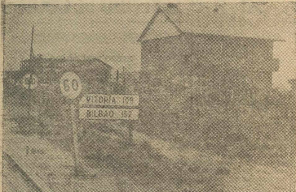
Carretera Madrid-Irún, salida de Burgos: cinco metros separan estas dos señales contrarias. Velocidad límite 60 kilómetros-hora; final de limitación de velocidad. Quizá se trate de gastar una broma al automovilista con prisa. Quizás sea obra de un espontáneo de la señalización.
