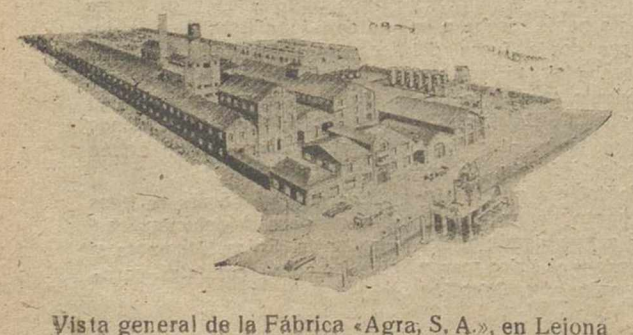
Vista general de la Fábrica «Agra, S. A.», en Lejona
