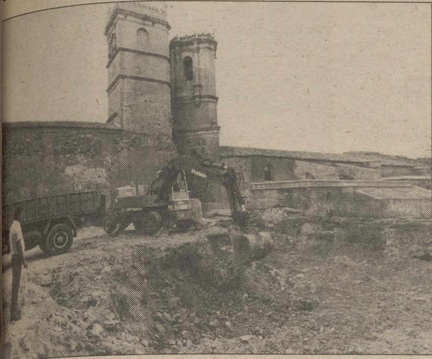
Máquinas excavadoras tras la fachada de la Lonja de Santo Domingo, lugar donde se ubicará el Centro Polivalente. Al fondo las torres del Tardón y de la Trinidad.
