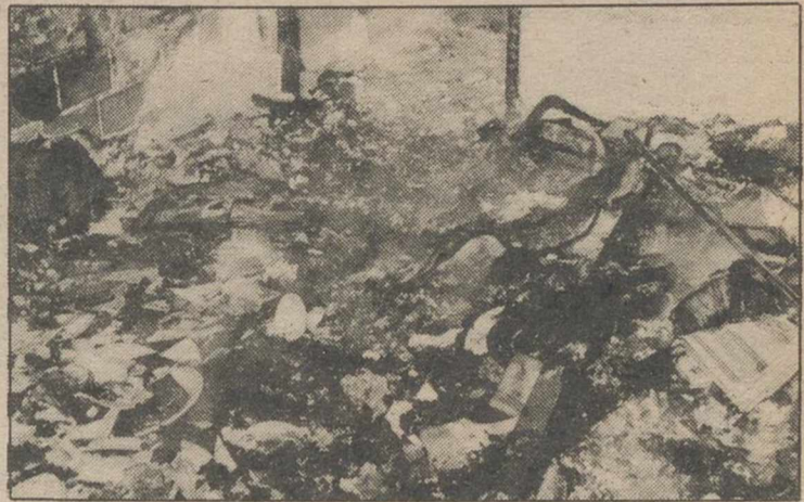
La vivienda quedó totalmente destruida.
