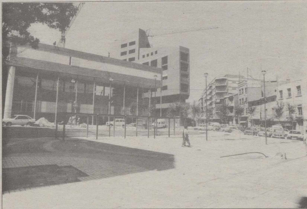
Las prisas en la entrega del colegio de Villacerrada han motivado que ahora no haya calefacción.
