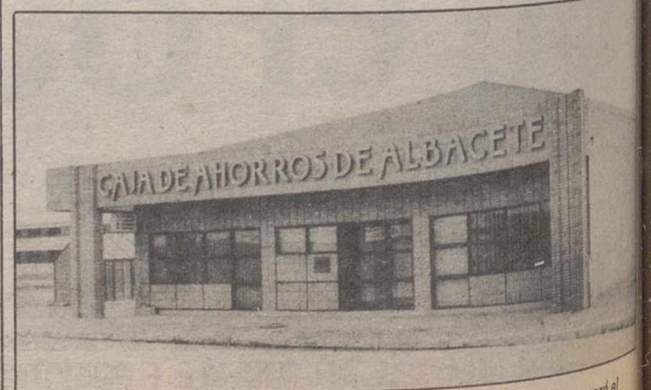
Edificio de la oficina en lo que en un próximo futuro será el “centro cívico”.
