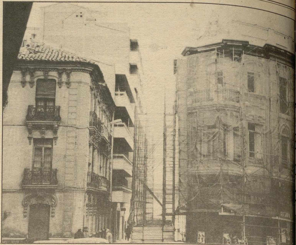
LAS OBRAS DE NUNCA EMPEZAR. —Ahí, en la esquina de Padre Romano y San Julián, están los andamios preparados desde el mes de septiembre, para las obras del Archivo Histórico Provincial. Molestias, por unas obras que parece que no van a empezar nunca, seguirán por ahora, hasta tanto concluyan los trámites administrativos del proyecto que ya tiene luz verde por parte de la Administración.
