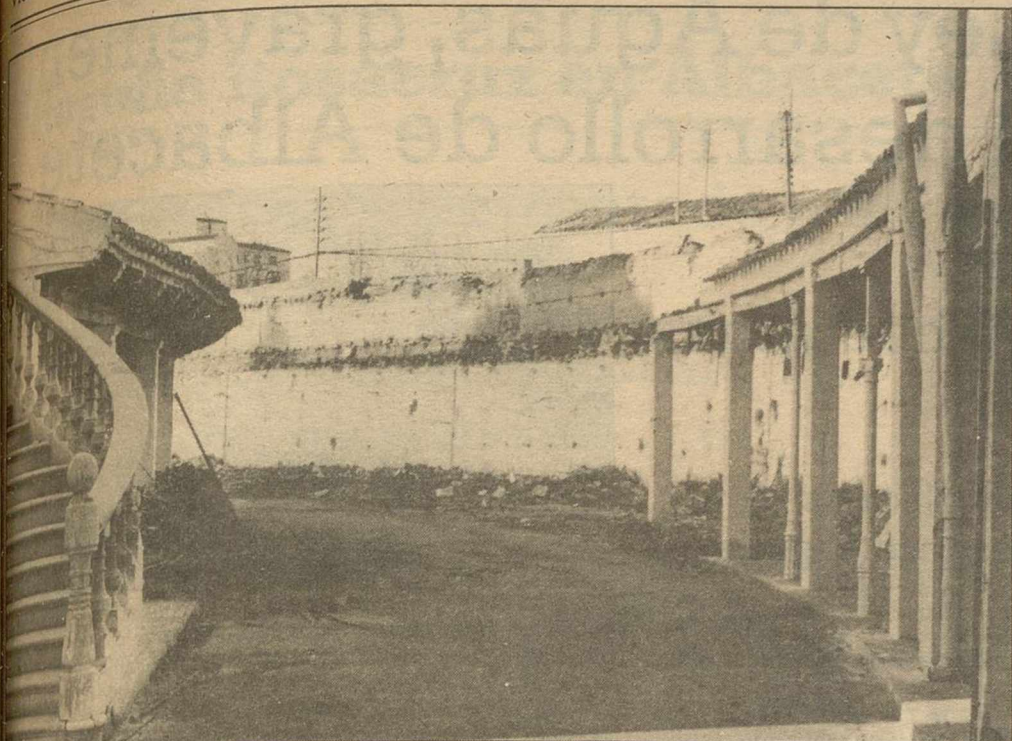
Obras en la Feria:
