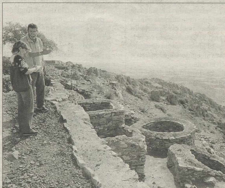
Silos utilizados como muralla y restos de ésta en La Encantada. / M. CIEZA
