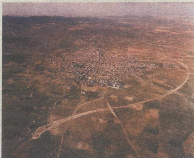
OBRA EN EJECUCIÓN: VARIANTE DE LA POBLACIÓN DE VILLARRUBIA DE LOS OJOS. CIUDAD REAL
