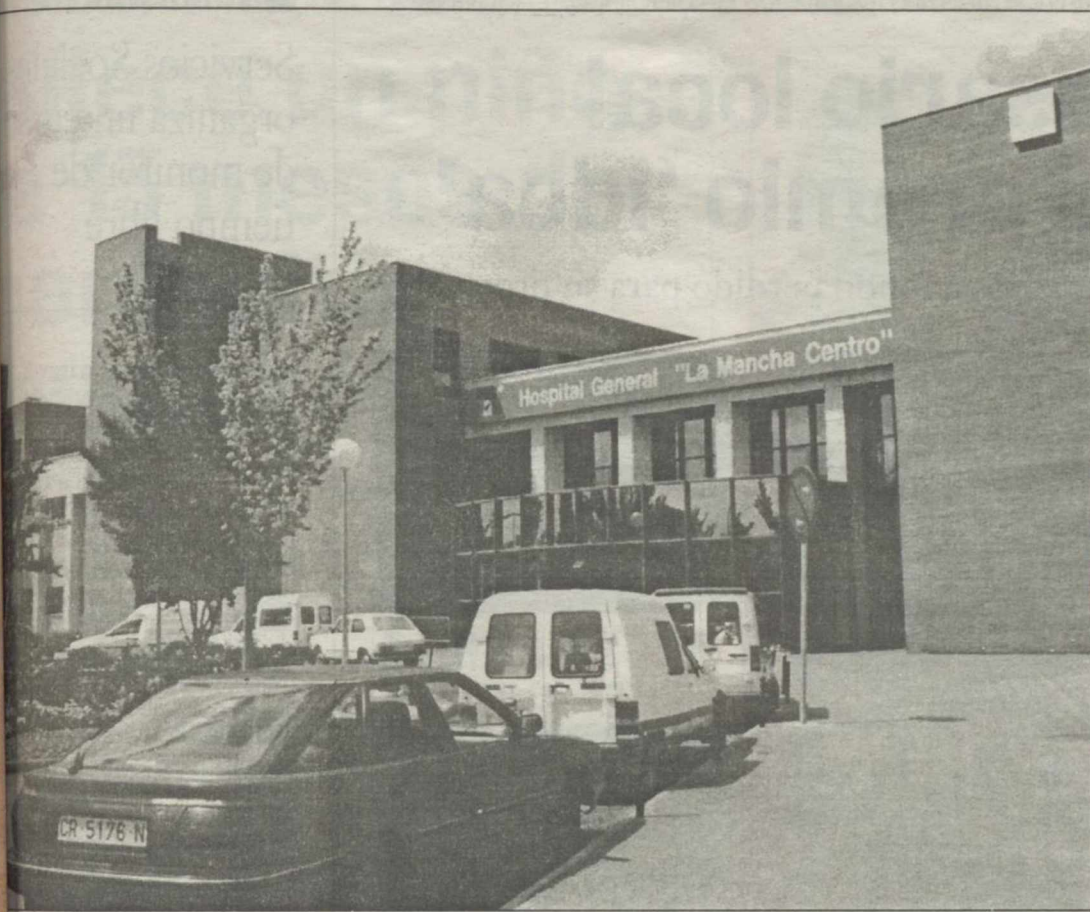
fachada de 'La Mancha Centro', en Alcázar de San Juan
