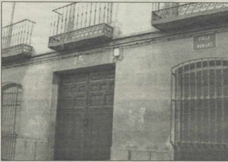
Estará ubicada en la calle Monjas
