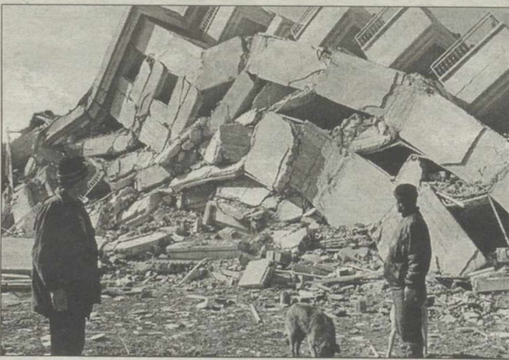
Unos supervivientes miran un edificio derruido en Afyon
