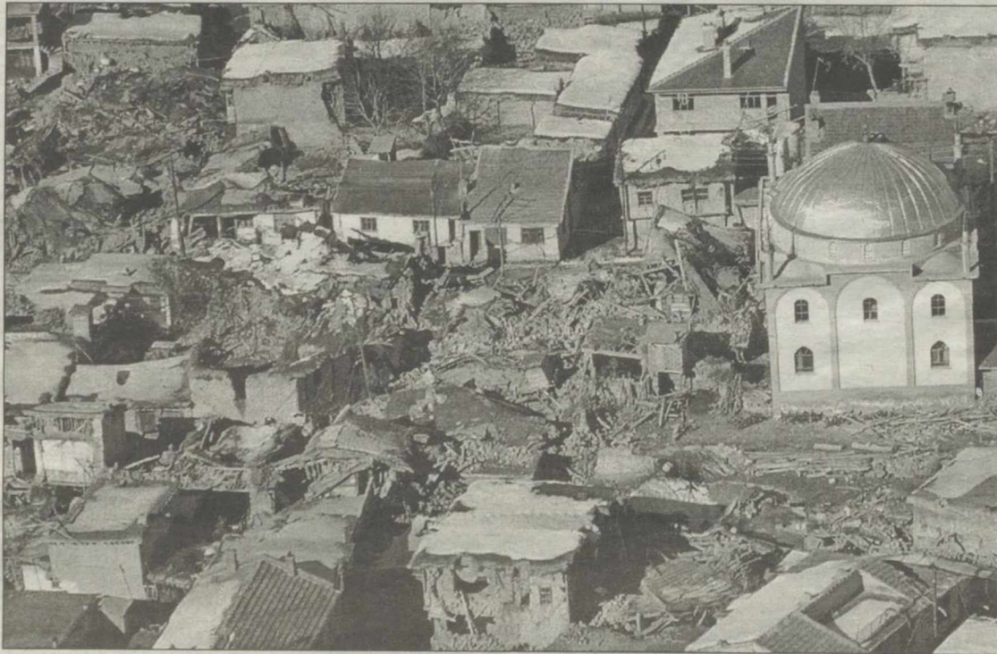
Vista aérea de los daños que originó el seísmo en la ciudad turca de Sultandagi
