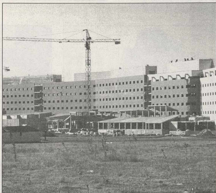
Ya se puede apreciar la estructura completa
