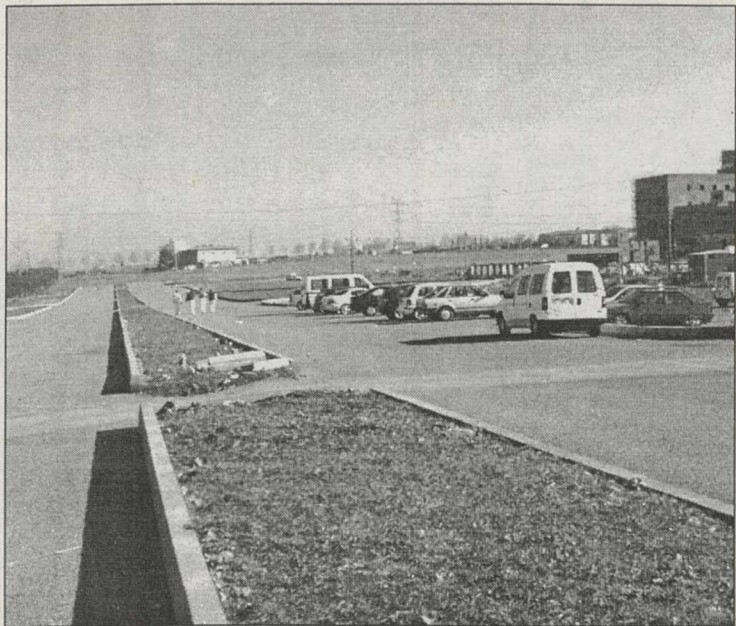
También ha quedado acondicionado el acerado
