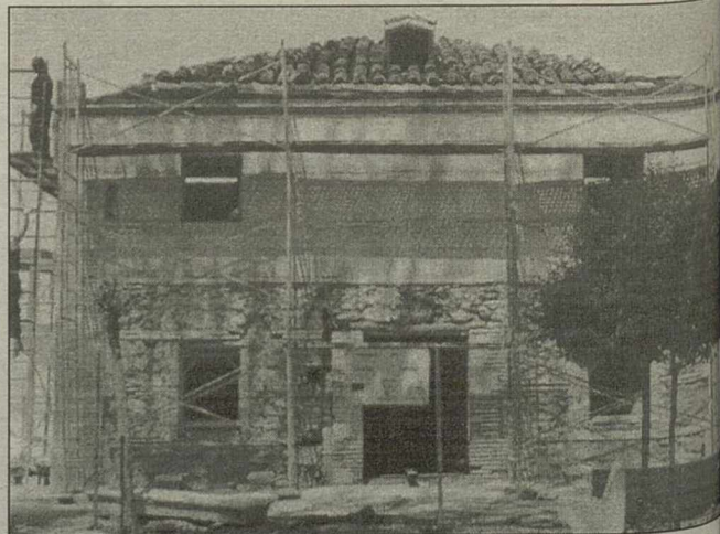
La casa del pintor Agustín Úbeda antes y durante las obras
