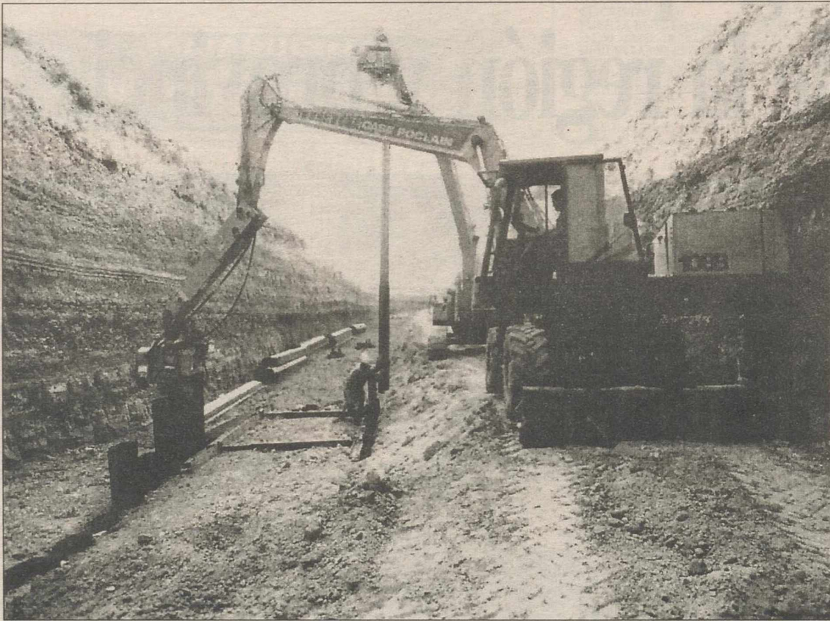
Imagen de las obras de la primera fase del colector.
