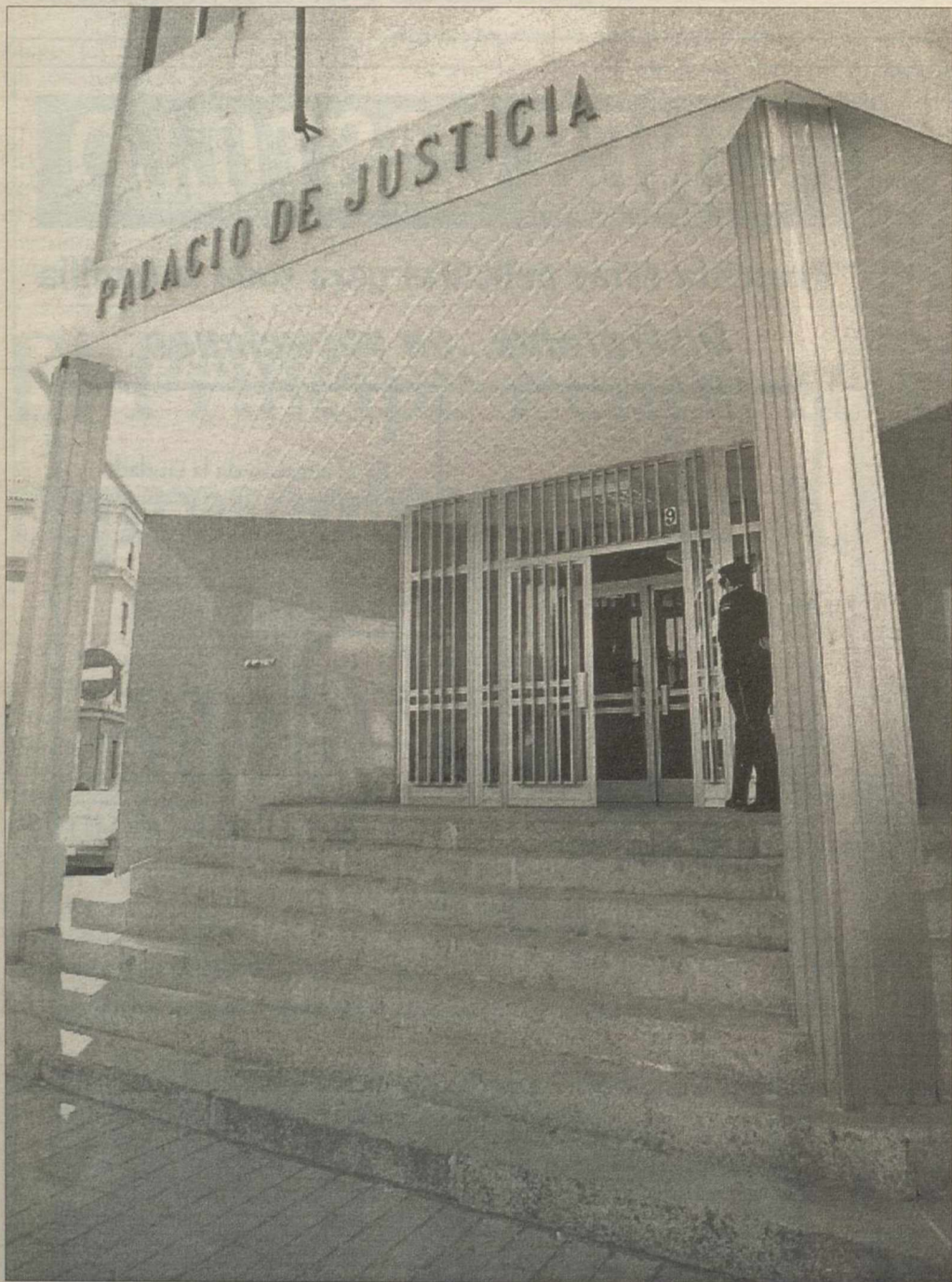
Aún hay edificios en los que no han sido eliminadas las barreras arquitectónicas.
