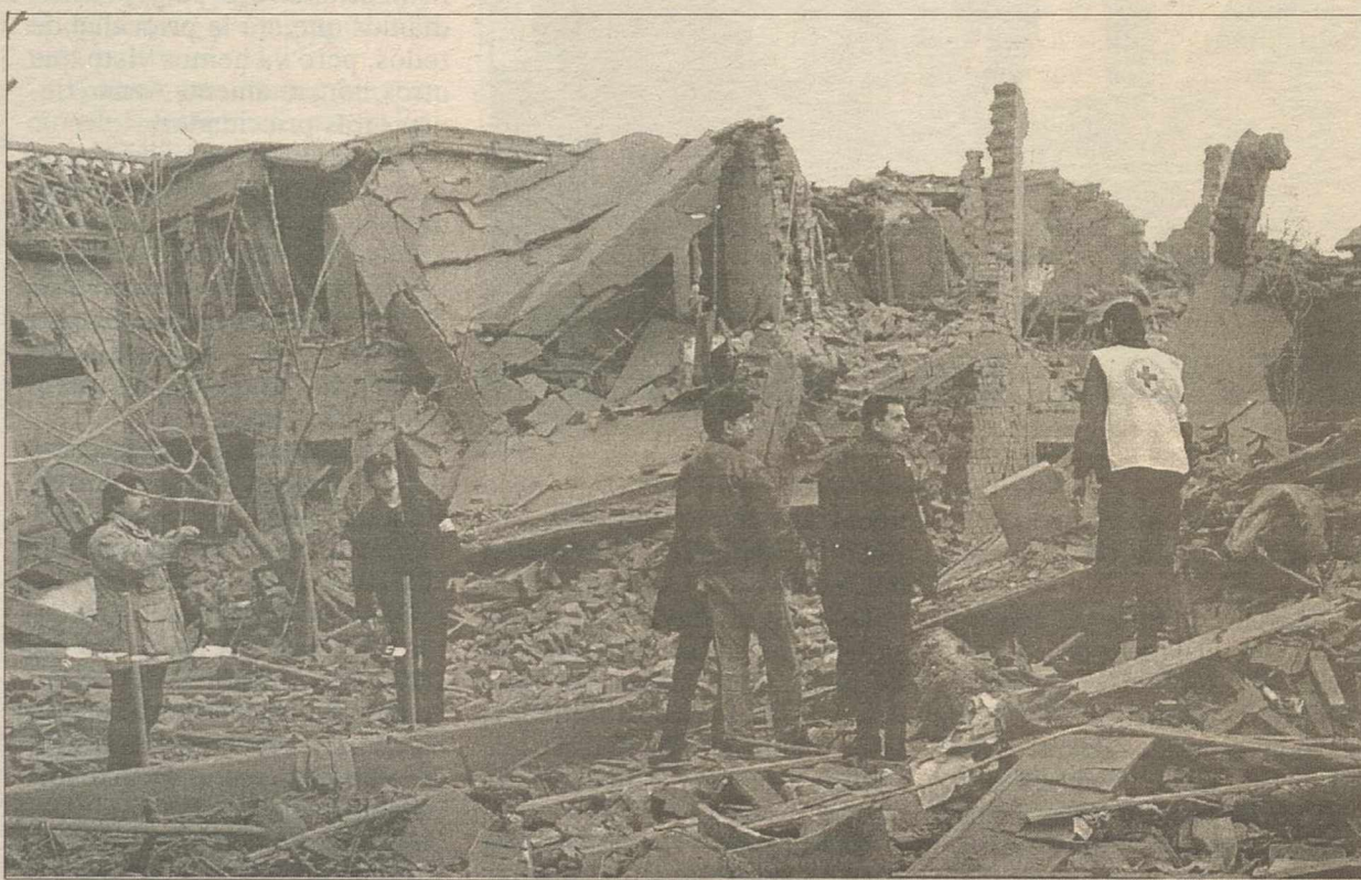
Estado en que quedó un grupo de viviendas en el pueblo de Aleksinac.
