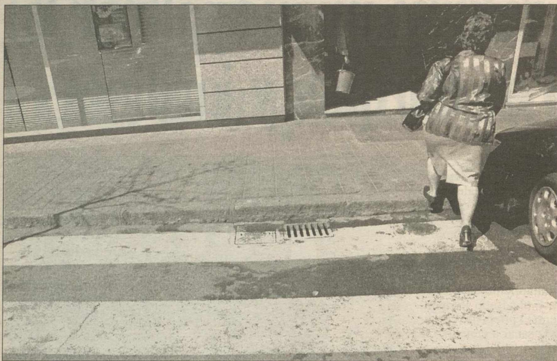
Todavía quedan bordillos sin rebajar.
