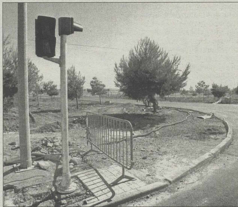
Instalación de nuevos semáforos en la zona del nuevo Hospital General de Ciudad Real. La foto de RUEDA muestra cómo los alrededores de la zona en la que, próximamente, se instalará el nuevo Hospital de Ciudad Real cuentan ya con semáforos en los cruces para que en los próximos meses, regulen la circulación del tráfico en la zona, que se espera sea una de las de mayor afluencia.
