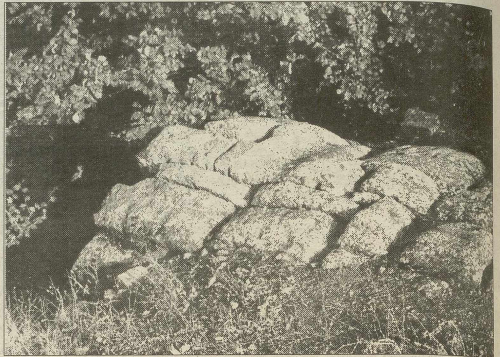
Aspecto que presenta el puente sobre el río Jabalón.
