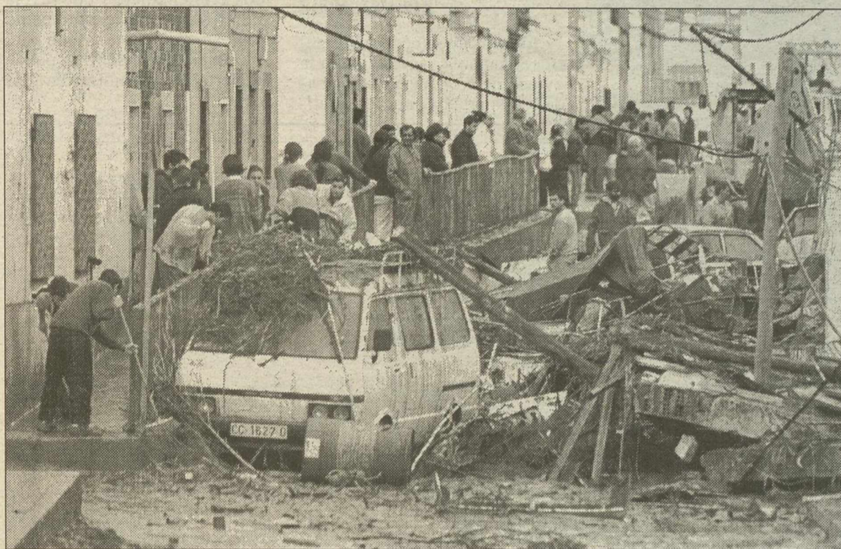
El temporal asoló algunas zonas de Extremadura, causando cuantiosas pérdidas.
