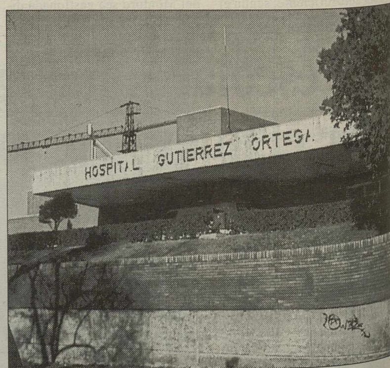
Dos de los quirófanos del Hospital empiezan de nuevo a funcionar esta semana.
