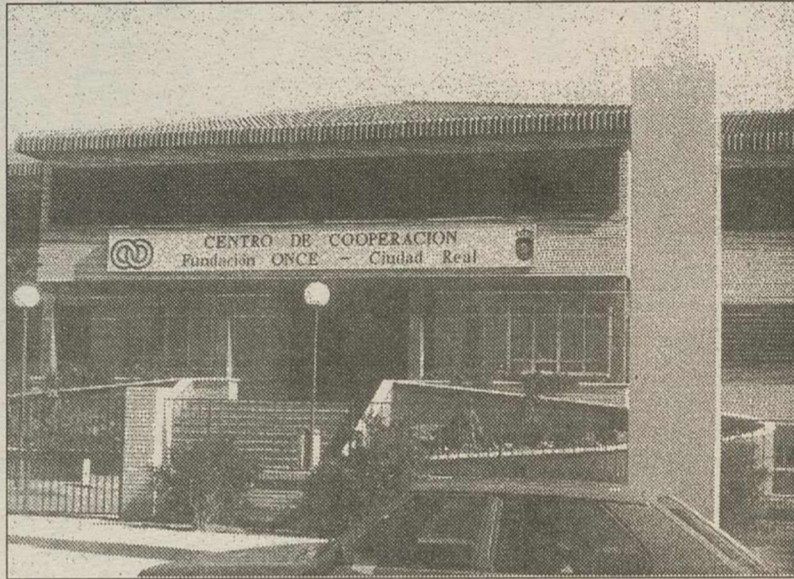
Fachada del Centro ONCE.
