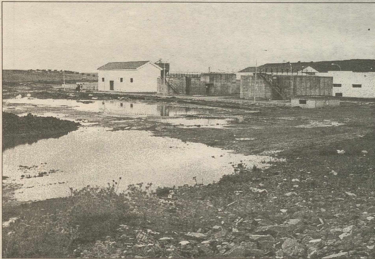
La potabilizadora se encuentra en la última fase de construcción.
