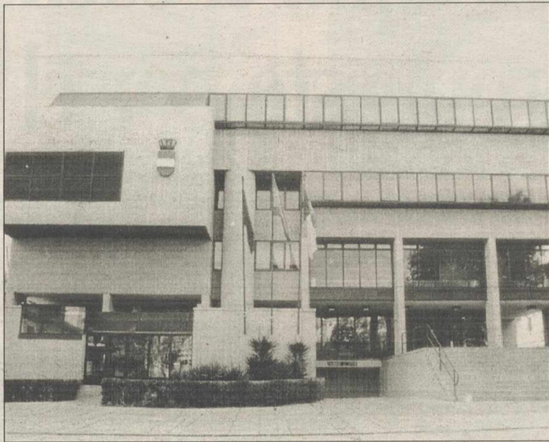
Esta medida sólo afecta a la Casa Consistorial.
