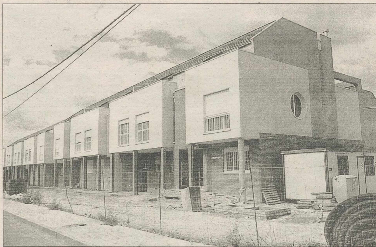
Las trece viviendas de Torrenueva serán unifamiliares de dos plantas.
