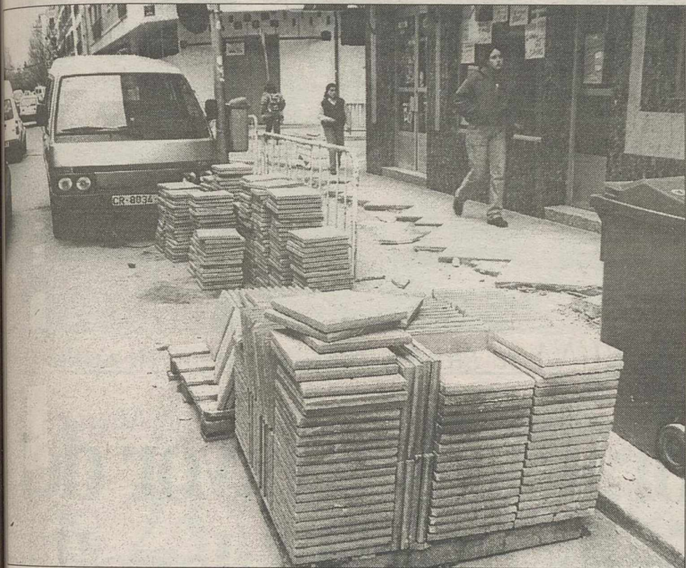
Calatrava es una de las calles que está siendo acerada.
