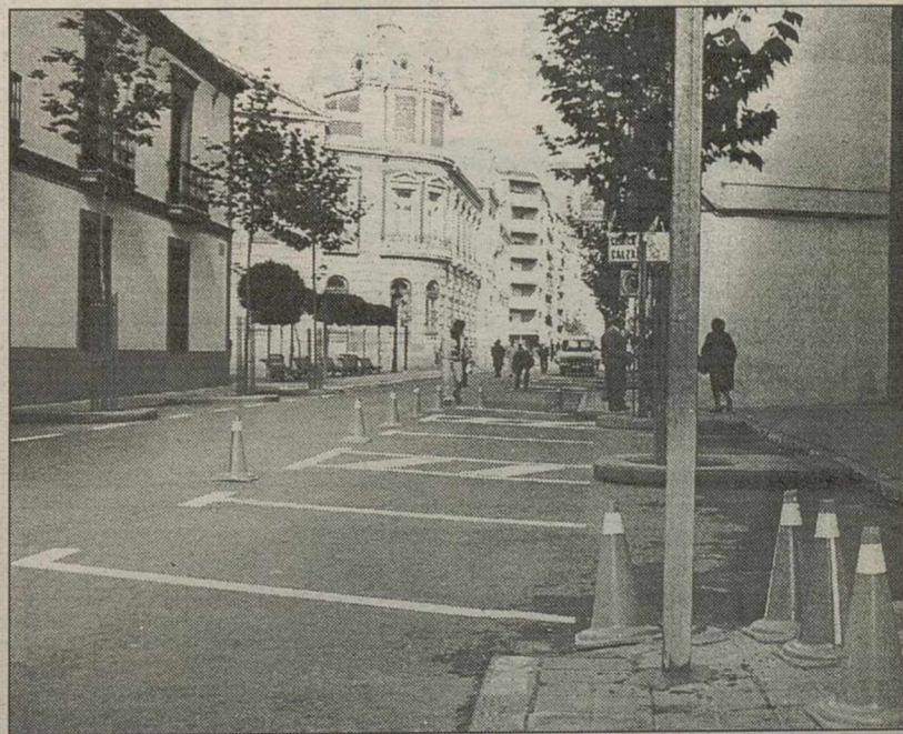
La calle Toledo está siendo pintada y señalizada en estos días.
