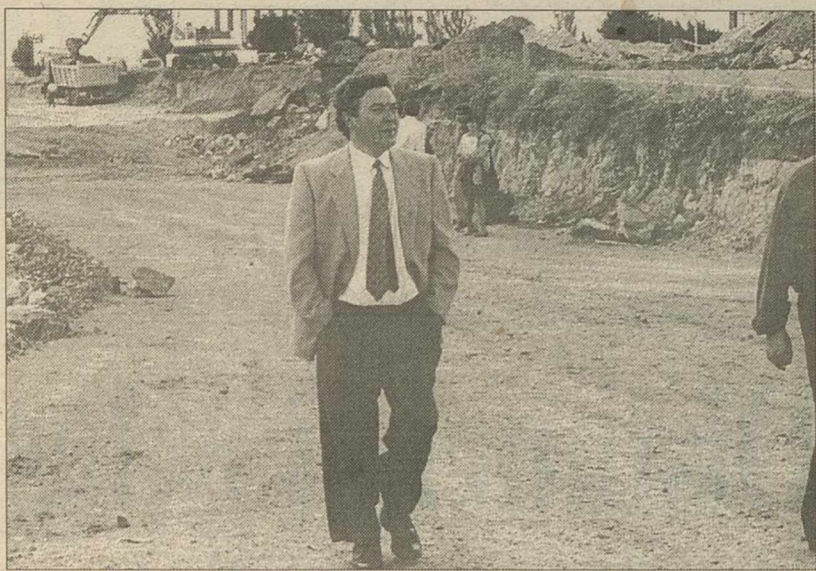
El alcalde, durante la visita a las obras del puente de Miguelturra.
