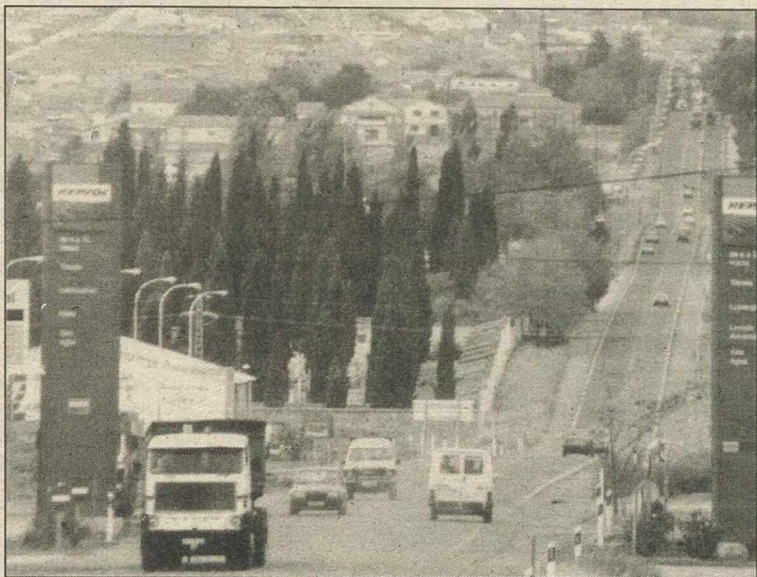
La Avenida de Andalucía será remodelada.
