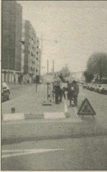
Trabajos en la ronda.
