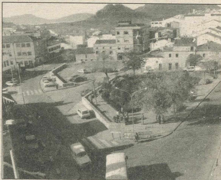
López Heredia visitará las obras que su departamento ejecuta en Almadén.
