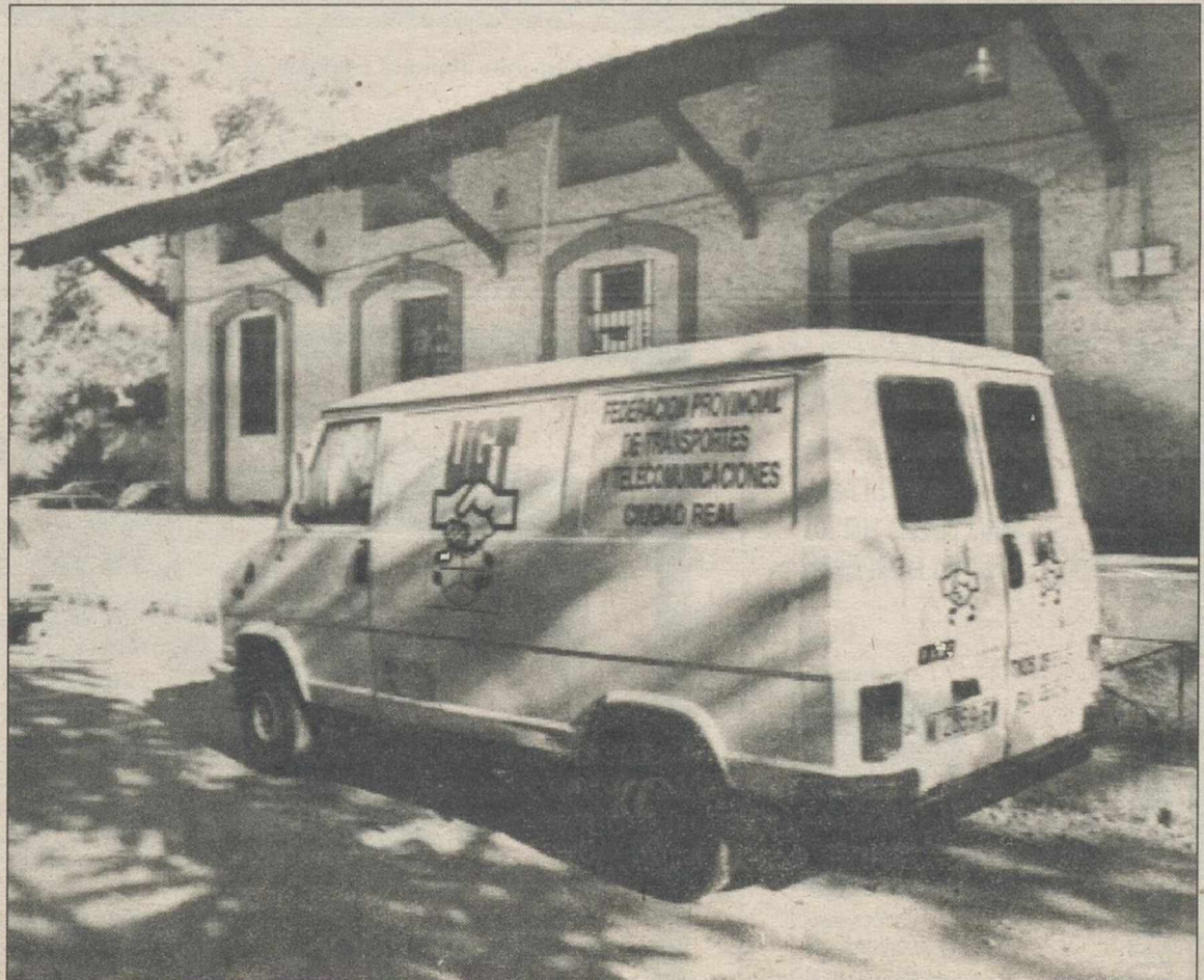
El antiguo muelle de carga que ocupa UGT-Transportes, situado frente al edificio al que pretendía trasladarse.
