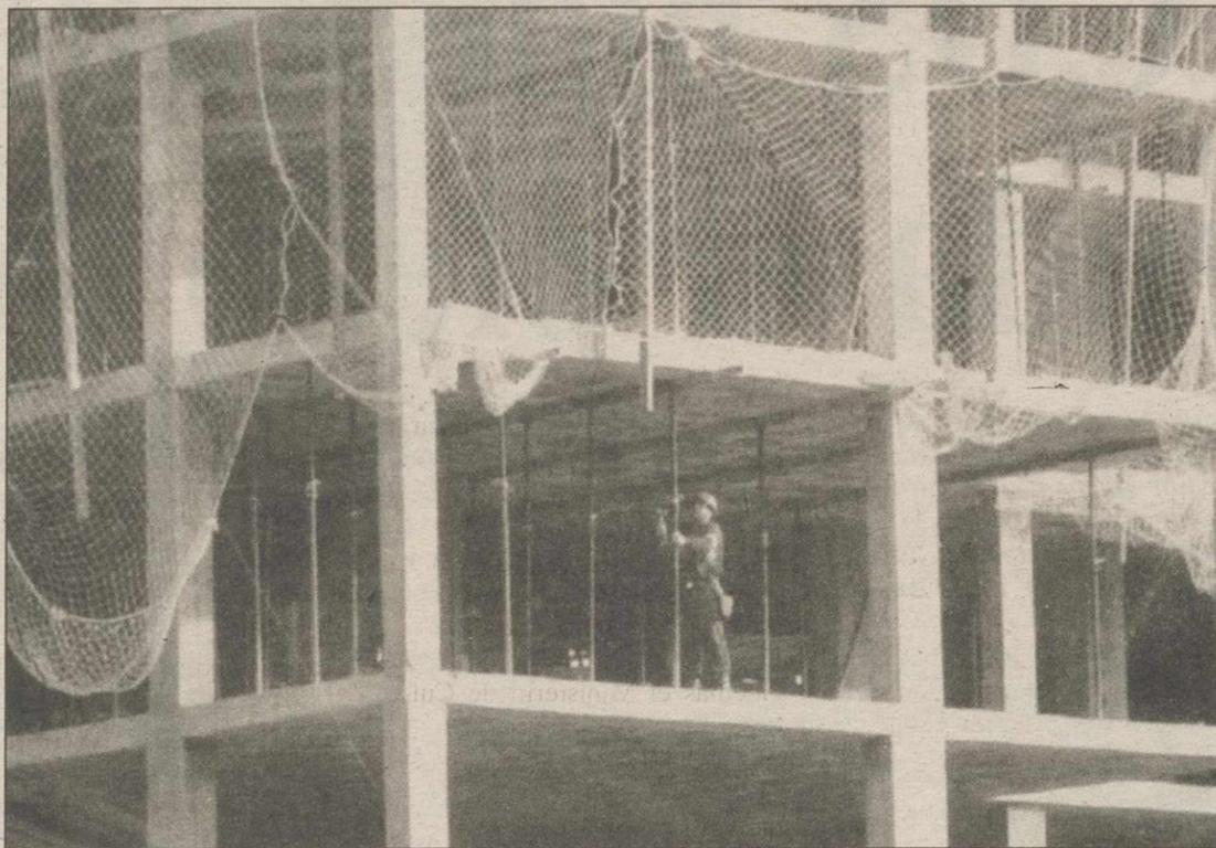
Algunas obras carecen de las medidas de seguridad o tienen, como se ve en la foto, la red mal colocada.
